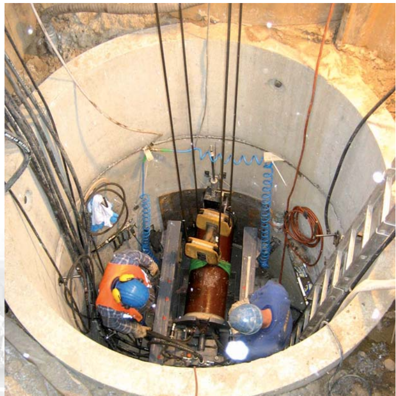
Blick in die Pressbaugrube
