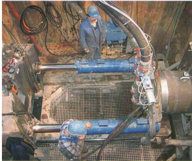
Einrichten der Vortriebsmaschine in der Startbaugrube
